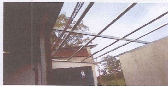
Foto 6: SUSTITUCIÓN DE LAMINA POR LAMINA TROQUELADA C26
