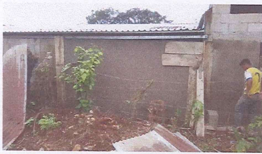
Foto 3: REPARACION DE PARED EN AULA, REPELLO Y CERNIDO CON CONCRETO
