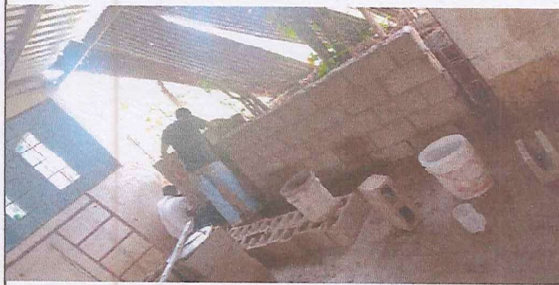
Foto 4: REPARACION DE PARED EN AULA, REPELLO Y CERNIDO CON CONCRETO
