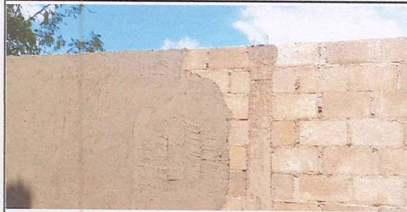
Foto 2: REPARACION Y SUSTITUCION DE MURO PERIMETRAL 72 METROS CUADRADOS
