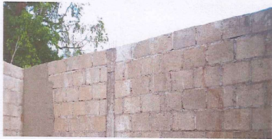
Foto 1: REPARACION Y SUSTITUCION DE MURO PERIMETRAL 72 METROS CUADRADOS
