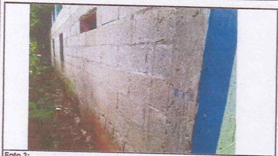
Foto 3: REPARACION DE PARED EXTERIOR EN 1 AULA
