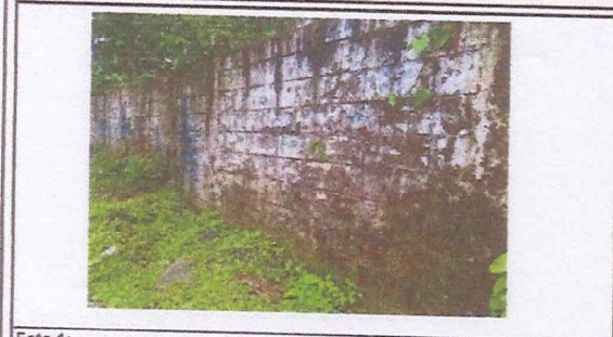
Foto 1: SUMINISTRO Y REPARACIÓN DE MURO PERIMETRAL
