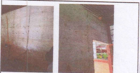
Foto 4: REPARACION DE PARED INTERIOR EN 1 AULA
