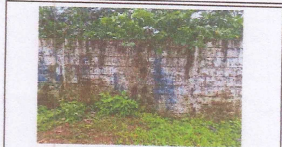
Foto 2: SUMINISTRO Y REPARACIÓN DE MURO PERIMETRAL
