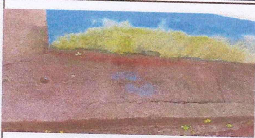
Foto 7: REPARACION Y MANTENIMIENTO DE BANQUETAS
