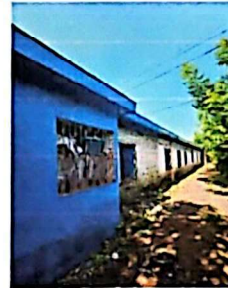
Foto 8: Mantenimiento de Balcones
