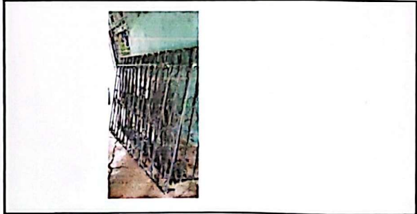
Foto 2: Sustitución de balcones de metal
