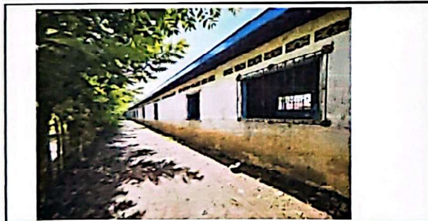
Foto 3: Instalación de Ventanas de Metal
