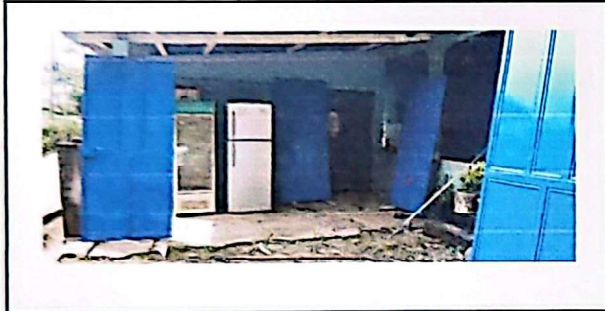
Foto 1: Sustitución de puertas nuevas de metal con Chapa Yale
