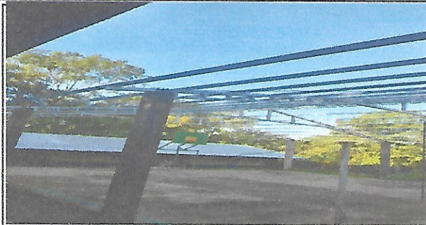
Suministro e instalacion de estructura metalica cancha
