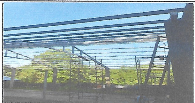
Suministro e instalacion de lamina troquelada C26 cancha
