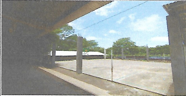
Suministro e instalacion de estructura metalica cancha
