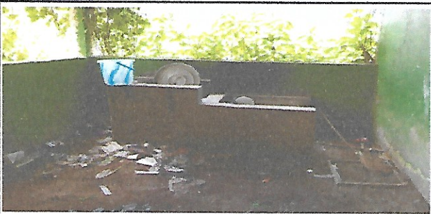
Suministro y sustitucion de torta de concreto cocina
