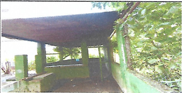
Suministro y sustitucion de estructura metalica y lamina troquelada cocina
