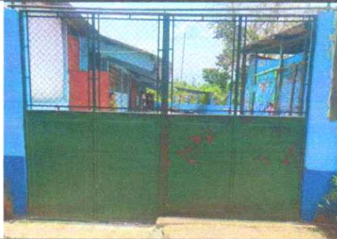
Foto 3: Suministro y sustitucion de porton de metal
