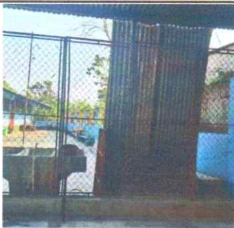
Foto 5: Suministro y sustitucion de muro de aula modulo 2
