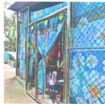
Foto 4: suministro y sustitucion de puerta de metal modulo 2
