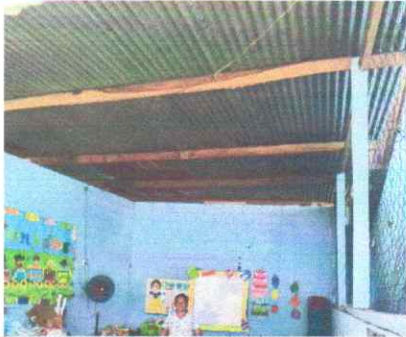
Foto1: suministro y sustitucion de estructura metalica aula modulo 2
