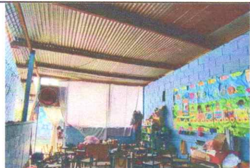
Foto 6: suministro y sustitucion de lamina C26 modulo 2
