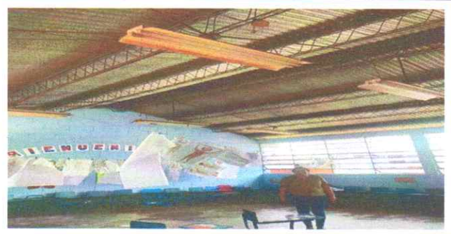
Foto2: sustitucion de sistema electrico modulo 1 y 2
