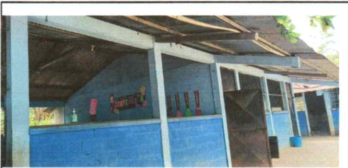
Suministro e instalación de balcones de hierro en ventana
