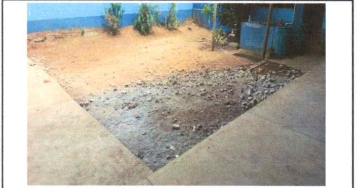
Suministro instalación piso concreto
