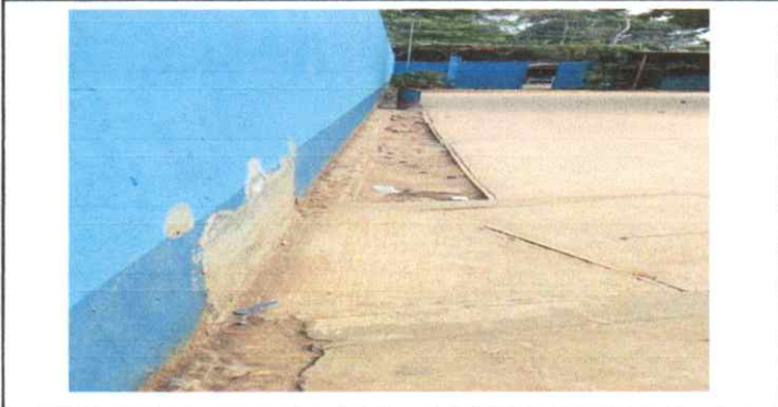
Suministro e instalación se cuneta concreto 30 mX0.50
