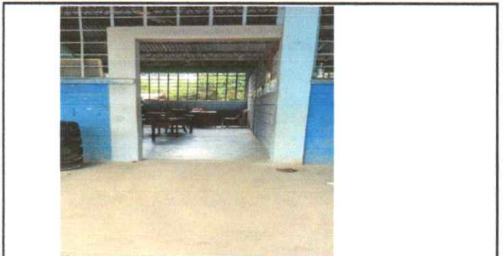
Fabricación e instalación de puerta de metal 2x1m
