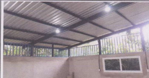
Foto 2: Suministro e instalación de sistema eléctrico
