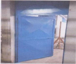
Foto 3: Suministro e instalación de 3 puertas de metal
