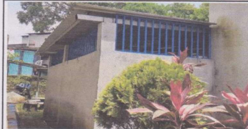
Foto 4: Suministro e instalación de Balcones de metal
