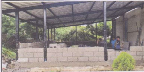
Foto 1: Suministro e instalación de muro de block para cubierta de aula
