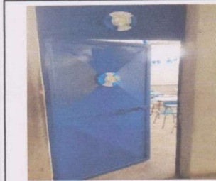
Foto 3: Suministro e instalación de 3 puertas de metal
