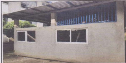
Foto 4: Suministro e instalación de Balcones de metal
