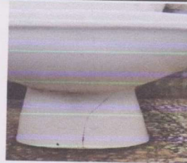
Foto 6: Cambio de Sanitarios por estar sin uso, por estar quebrados de la parte de abajo
