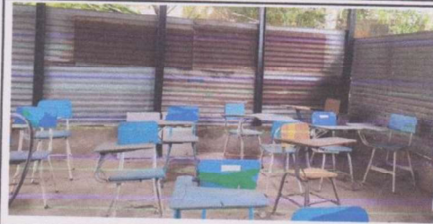
Mejoramiento de ambientes que cuenta con piso de torta de cemento
