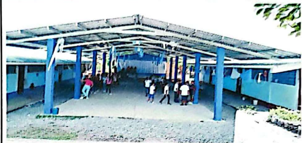
FOTO 2: sustitución de capote Maxalum calibre 26.
