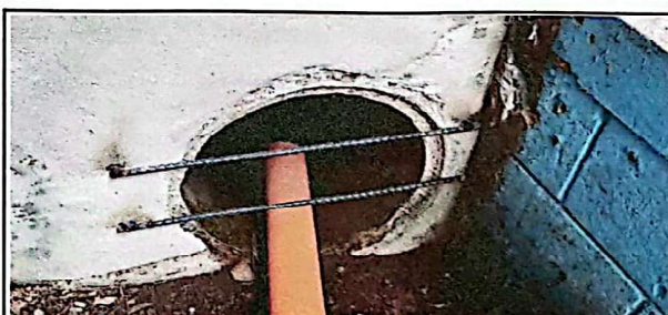
FOTO 6: sustitución de cuneta de concreto.
