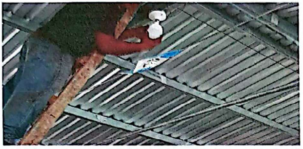
FOTO 7: sustitución de plafoneras.
