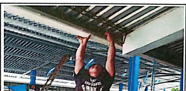
FOTO 4: sustitución de tubería PVC lineal principal agua pluviales.
