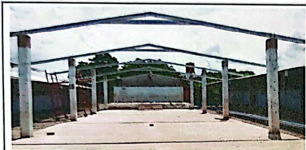
FOTO 3: sustitución de estructura de soporte de madera por metal.
