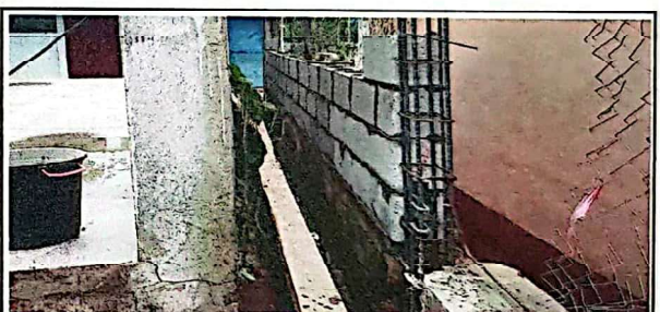
FOTO 6: sustitución de cuneta de concreto.
