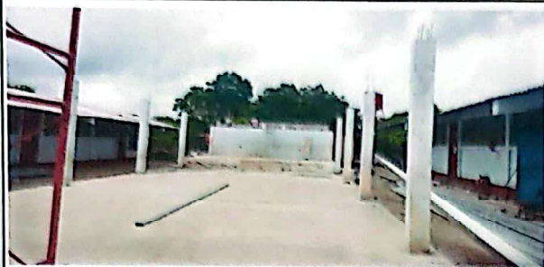
FOTO 1: sustitución de lámina por lámina troquelada calibre 26 en patio.
