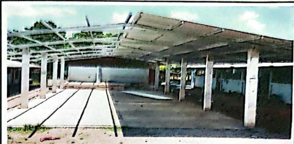
FOTO 2: sustitución de capote Maxalum calibre 26.
