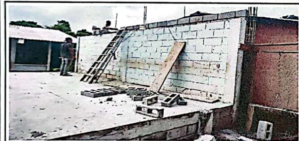
FOTO 5: sustitución de muro perimetral con barda de concreto.
