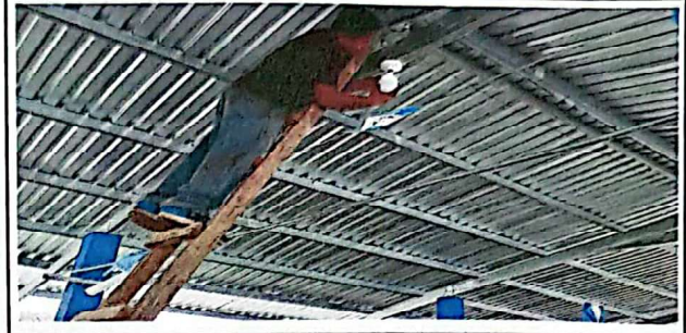
FOTO 8: sustitución de bombillas Led Globo 30 W.
