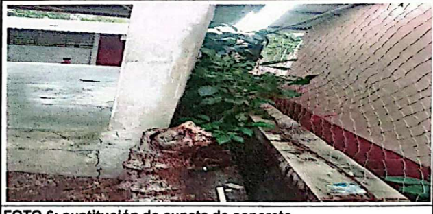
FOTO 6: sustitución de cuneta de concreto.
