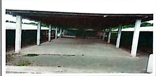
FOTO 8: sustitución de bombillas Led Globo 30 W.
