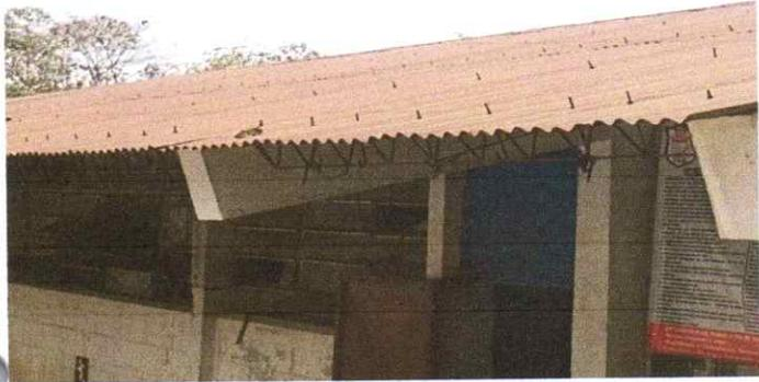
Sustitución de lámina, por lámina troquelada aluzinc calibre 26 mas estructura yoys
