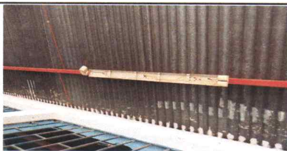
Foto 5: Reparacion de sistema electrico
