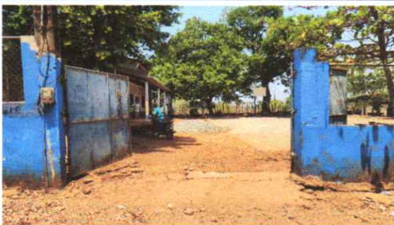
Sustitución de Porton metalico.
