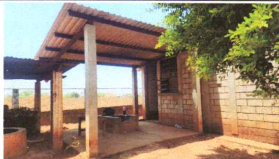
Suministro e instalacion de paredes en cocina, reparacion de estufa rural.
