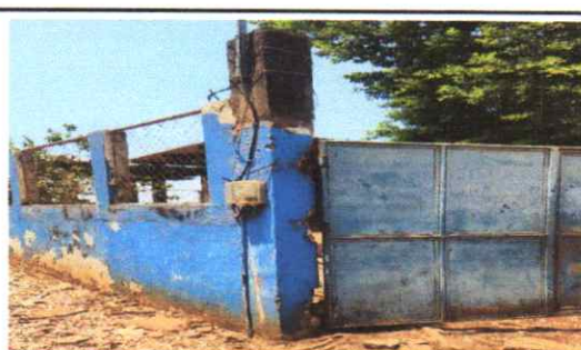
Foto 6: Suministro e instalacion de muro de concreto.
