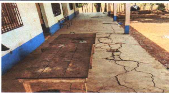
Foto 3: Sustitucion de piso de concreto
