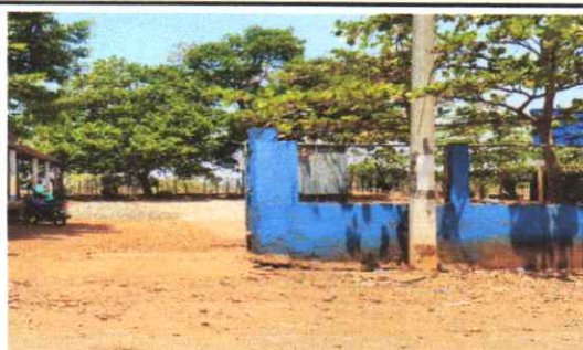
Foto 4: Suministro e instalacion de piso en area deportiva
