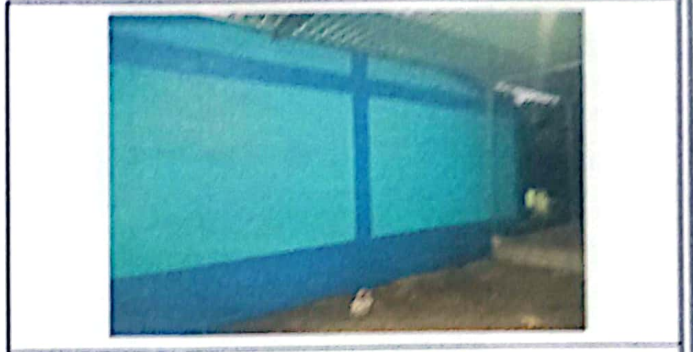
Foto 2: SUMINISTRO Y APLICACIÓN DE PINTURA EN PAREDES INTERIORES Y EXTERIORES
