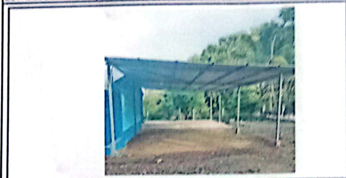
Foto 1: REPARACION DE TORTA DE CONCRETO DE ESCENARIO
