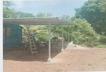
Foto 2: INSTALACION DE ESTRUCTURA METALICA GALVANIZADA EN SALON
