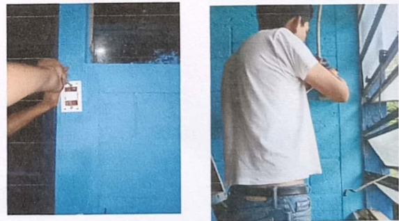
Foto 6: REPARACION DE SISTEMA ELECTRICO DE AULAS
