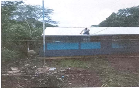
Foto 3: SUMINISTRO E INSTALACION DE CANAL Y BAJADA DE AGUA PLUVIAL
