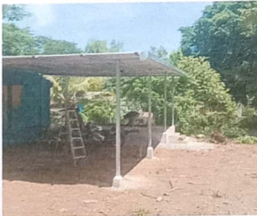
Foto 5: SUMINISTRO E INSTALACIÓN DE BASE METÁLICA PARA SOPORTE DE ESTRUCTURA DE SALON
