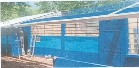
Foto1: SUMINISTRO E INSTALACION DE LAMINA TROQUELADA C 26
