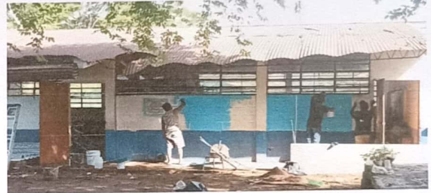
Foto 4: APLICACIÓN DE PINTURA EN PAREDES
