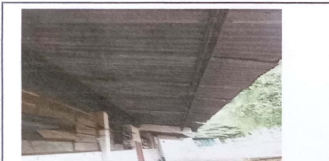
Foto 5: MANTENIMIENTO A ESTRUCTURA DE SOPORTE
