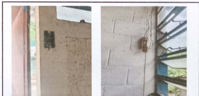
Foto 6: REPARACION DE SISTEMA ELECTRICO DE AULAS
