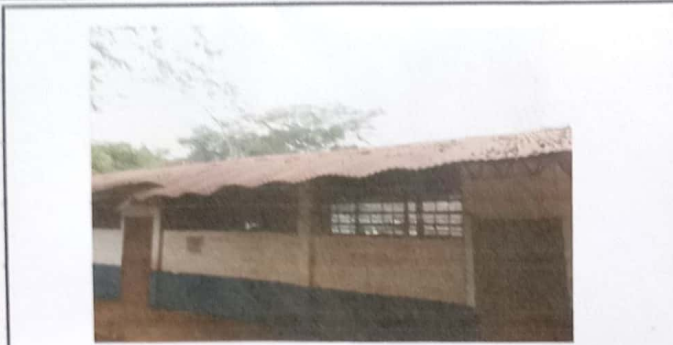
Foto 1: SUMINISTRO E INSTALACION DE LAMINA TROQUELADA C 26
