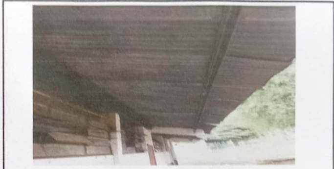
Foto 2: SUMINISTRO E INSTALACIÓN DE ESTRUCTURA DE SOPORTE DE LAMINA
