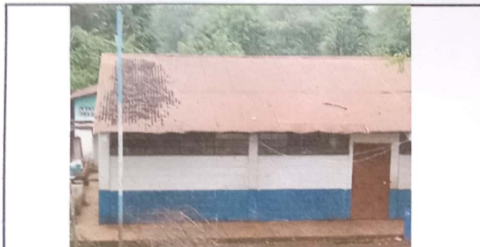
Foto 3: SUMINISTRO E INSTALACION DE CANAL Y BAJADA DE AGUA PLUVIAL
