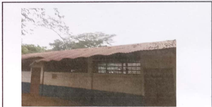
Foto 4: APLICACIÓN DE PINTURA EN PAREDES
