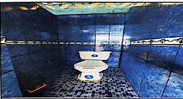
Foto 5: Sustitución de sanitario
