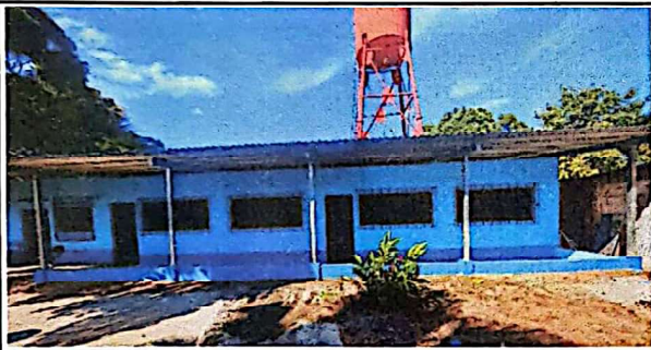
Foto 3: Sustitución de lámina troquelada
