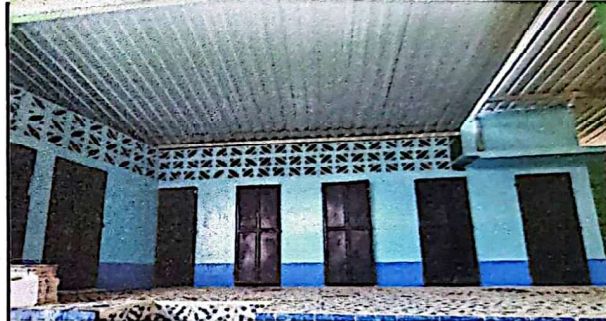
Foto 4: Sustitución de lámina troquelada
