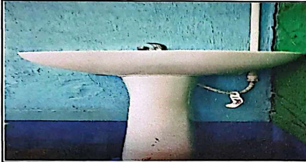
Foto 7: Suministro de lavamanos y accesorios
