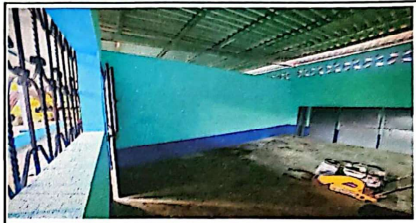
Foto 2: Reparación de muro de aulas
