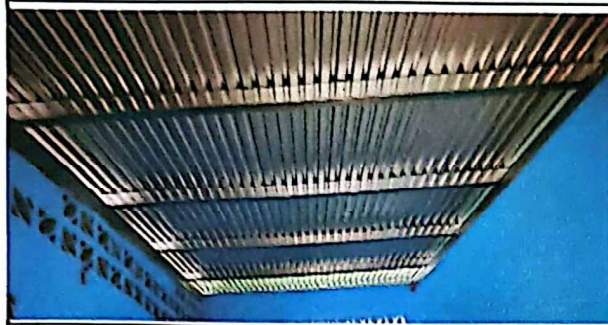
Foto 1: Sustitución de estructura metálica
