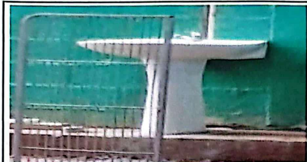
Foto 7: Suministro de lavamanos y accesorios
