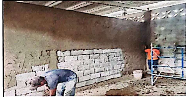
Foto 2: Reparación de muro de aulas
