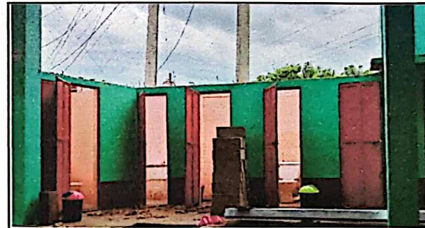
Foto 4: Sustitución de lámina troquelada
