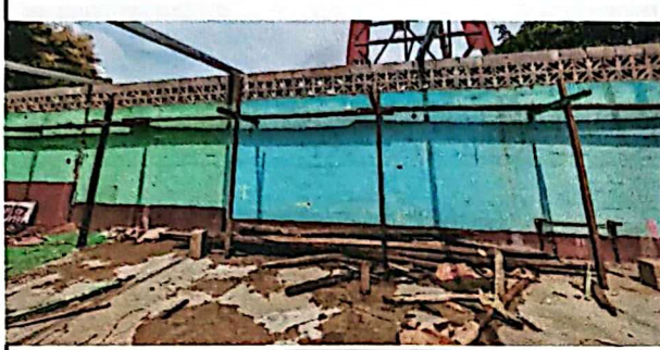
Foto1: Sustitución de estructura metálica
