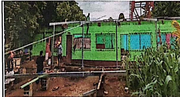
Foto 3: Sustitución de lámina troquelada
