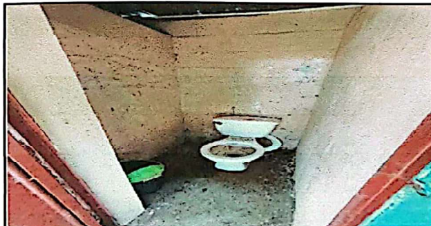
Foto 5: Sustitución de sanitario
