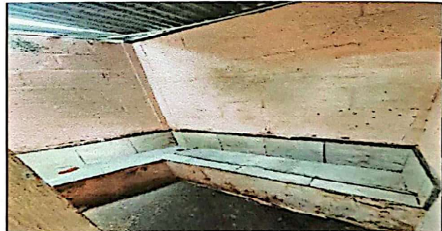
Foto 6: Sustitución de mingitorio
