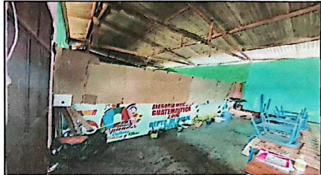
Foto 2: Reparación de muro de aulas
