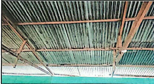
Foto1: Sustitución de estructura metálica
