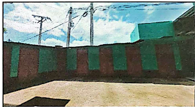
Foto 4: Sustitución de lámina troquelada
