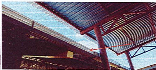
Foto 3: INSTALACION DE CANALES
