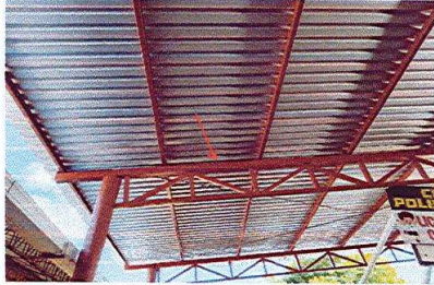
Foto 1: INSTALACION DE ESTRUCTURA METALICA
