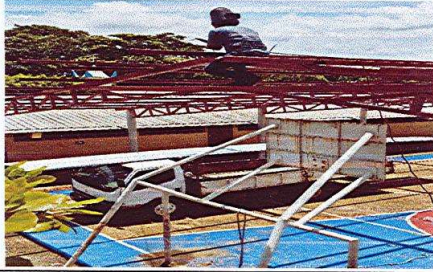
Foto 1: INSTALACION DE ESTRUCTURA METALICA
