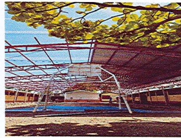
Foto 2: INSTALACION DE LAMINA TROQUELEADA
