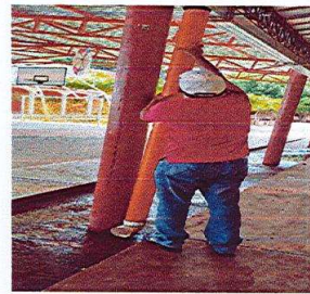
Foto 4: INSTALACION BAJADA DE AGUA PLUVIAL
