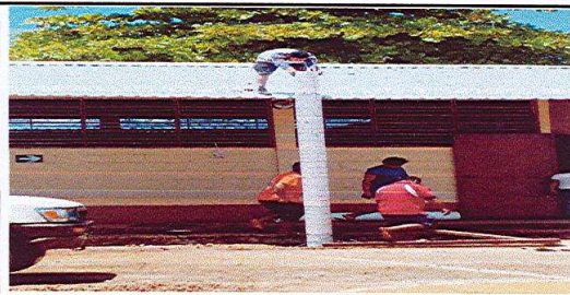
Foto 5: INSTALACION DE CIMENTACION
