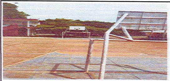
Foto 5: INSTALACION DE CIMENTACION
