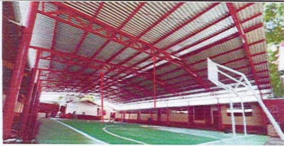
Foto 1: SUMINISTRO DE ESTRUCTURA METALICA
