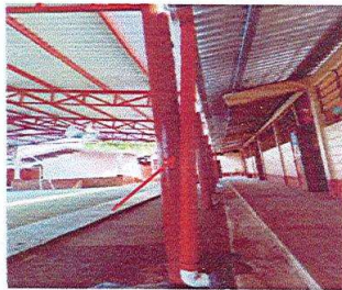
Foto 3: SUMINISTRO DE BAJAS DE AGUA PLUVIAL
