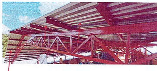
Foto 4: SUMINISTRO DE LAMINA TROQUELEADA
