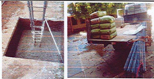
Foto 5: SUMINISTRO DE CIMENTACION
