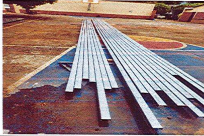
Foto 1: SUMINISTRO DE ESTRUCTURA METALICA
