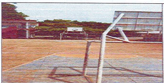
Foto 6: SUMINISTRO DE CIMENTACION
