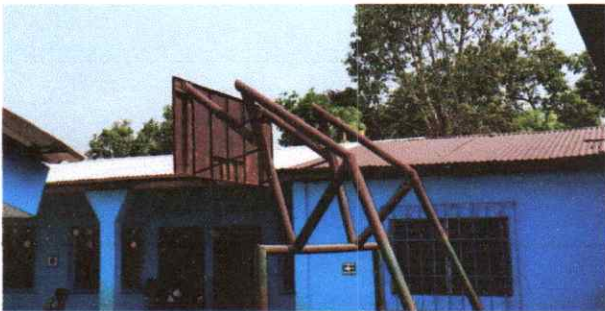
SUSTITUCION DE LAMINA ACANALADA CALIBRE 26
