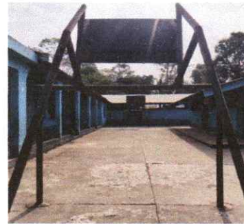
INSTALACION DE CUBIERTA METALICA, LAMINA TROQUELADA CALIBRE 26
