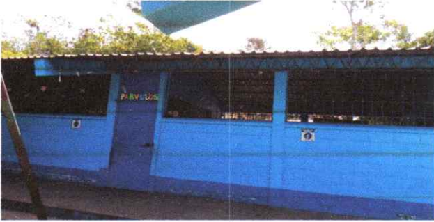
SUSTITUCION DE CANALES DE AGUA PLUVIAL
