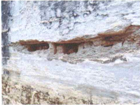
SUSTITUCIÓN DE PARED PERIMETRAL CON MUROS DE MAMPOSTERIA REFORZADAS CON ZAPATA DE 1x1 METROS
