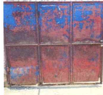
SUSTITUCIÓN DE PUERTA DE METAL 3x4m
