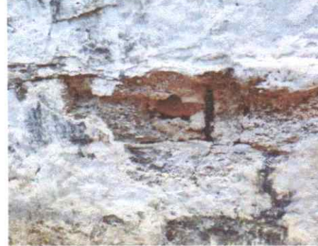
SUSTITUCIÓN DE PARED PERIMETRAL CON MUROS DE MAMPOSTERIA REFORZADAS CON ZAPATA DE 1x1 METROS
