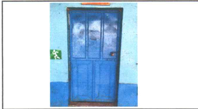
Sustitución de puertas de aulas
