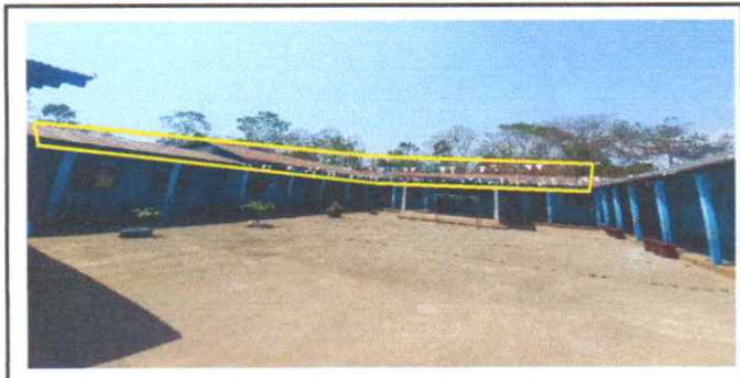
Sustitución de Cubierta de lámina, Foco de 15 Wats
