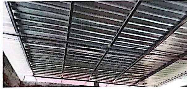
Foto 2: Suministro y sustitución de lamina troquelada C26
