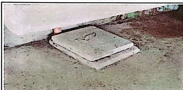
Foto 9: Suministro y reparación de drenaje de pila
