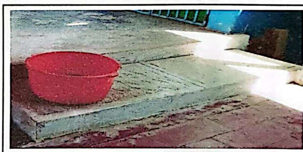
Foto 10: Suministro y reparación de gradas de concreto
