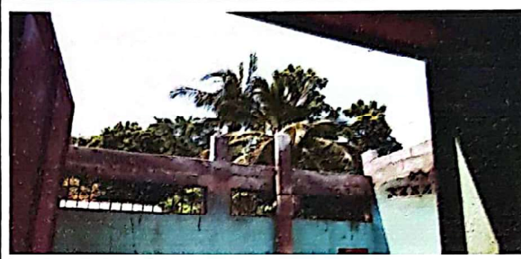
Foto 2: Suministro y sustitución de lamina troquelada C26
