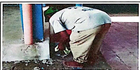
Foto 10: Suministro y reparación de gradas de concreto
