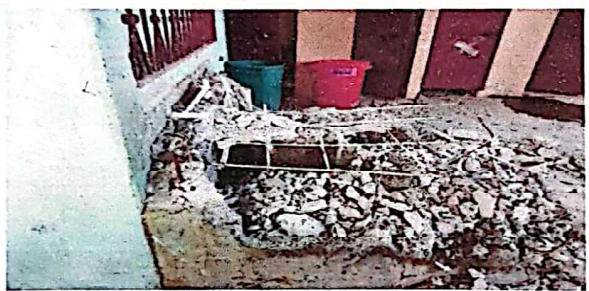
Foto 3: Suministro e instalación de pila de concreto
