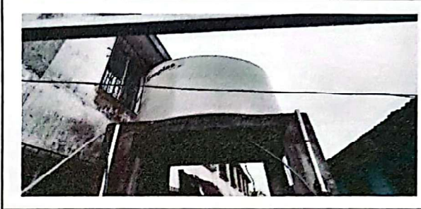
Foto 8: Suministro e instalación de deposito de agua 2500L
