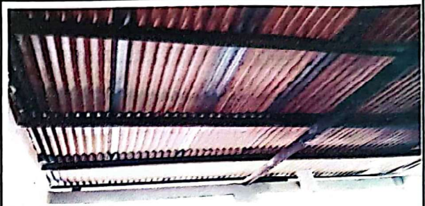
Foto 2: Suministro y sustitución de lamina troquelada C26
