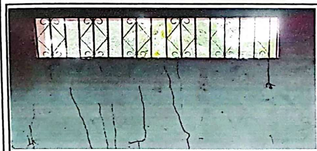
Foto 11: Suministro y instalación de balcón en cocina
