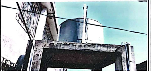
Foto 8: Suministro e instalación de deposito de agua 2500L
