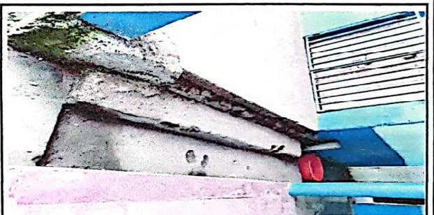
Foto 10: Suministro y reparación de gradas de concreto
