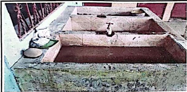
Foto 3: Suministro e instalación de pila de concreto
