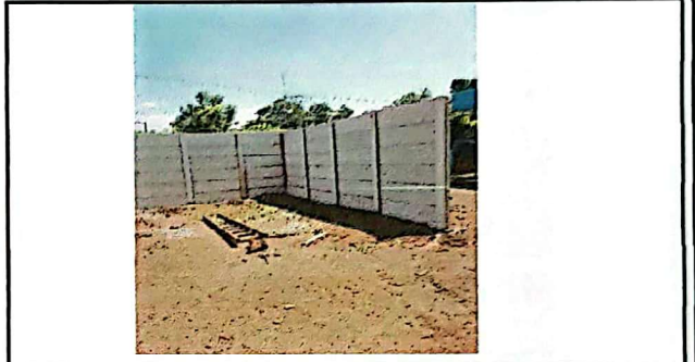
Foto 2: Suministro e instalacion de paredes prefabricadas para 2 aulas . Aula.2
