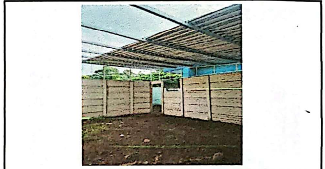
Foto 4: Suministro e instalacion de lamina troquelada aluzinc C26.
