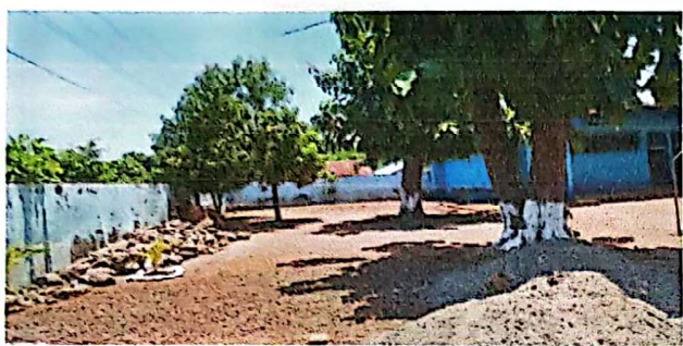
Suministro e instalación de paredes prefabricadas para 2 aulas
