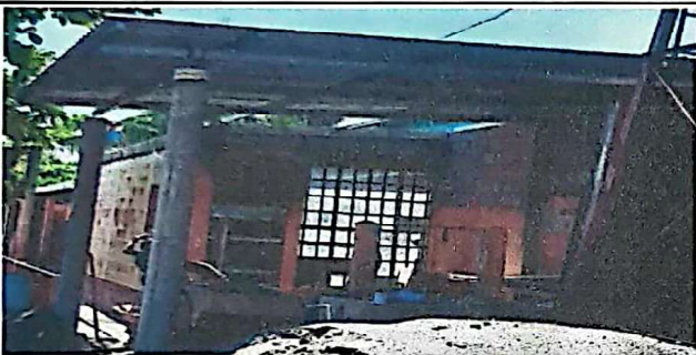
FOTO 3: Sustitución de lámina troquelada Aluzinc calibre 26 para techado de cocina
