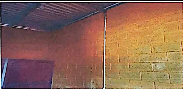
FOTO 5: Suministro y reparación de pared de cocina
