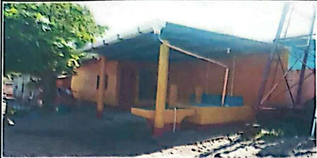
FOTO 7: Suministro e instalación de columnas
