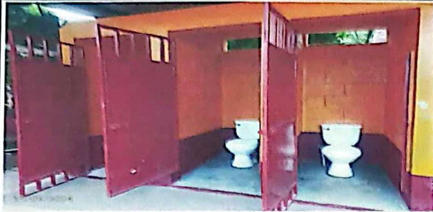
FOTO 1: Suministro e instalación de sanitarios lavables
