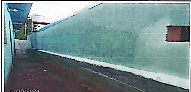
FOTO 6: Suministro y repello de pared de cocina
