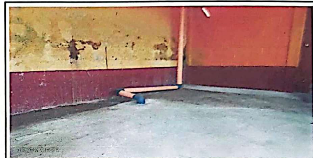
FOTO 10: Mantenimiento de fosa séptica
