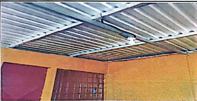
FOTO 9: Suministro e instalación de sistema eléctrico 150 mts
