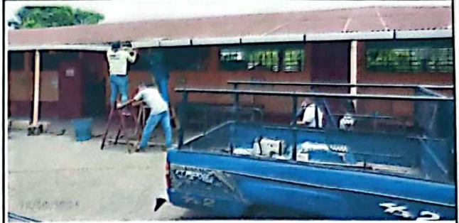
FOTO 14: Suministro y reparación de canales
