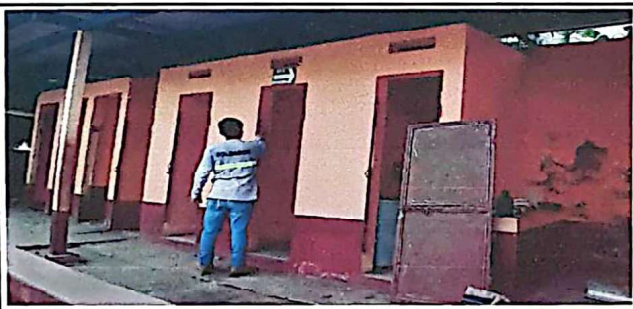
FOTO 11: Mantenimiento de pintado de puertas
