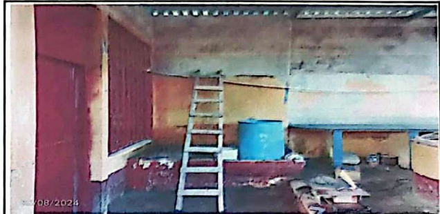
FOTO 8: Mantenimiento y remodelación de cocina
