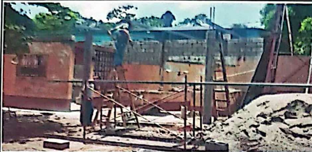
FOTO 7: Suministro e instalación de columnas
