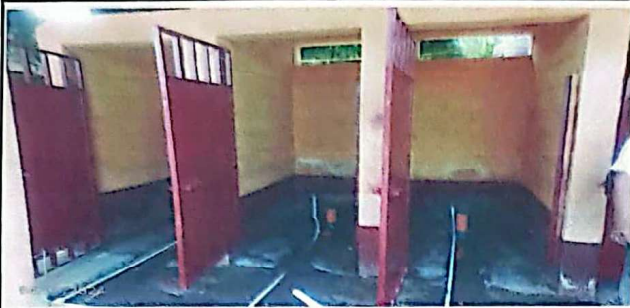
FOTO 1: Suministro e instalación de sanitarios lavables
