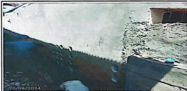
FOTO 6: Suministro y repello de pared de cocina
