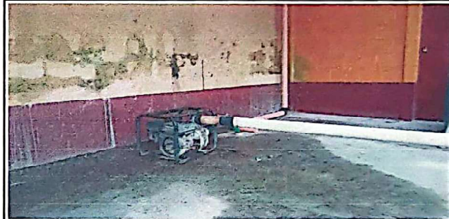
FOTO 10: Mantenimiento de fosa séptica
