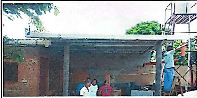
FOTO 4: Suministro e instalación de canales y bajadas de agua
