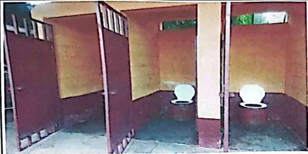
FOTO 1: Suministro e instalación de sanitarios lavables
