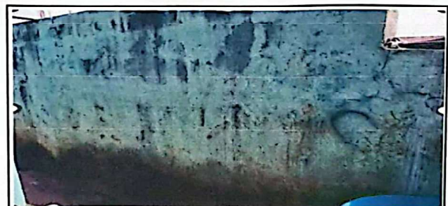
FOTO 6: Suministro y repello de pared de cocina
