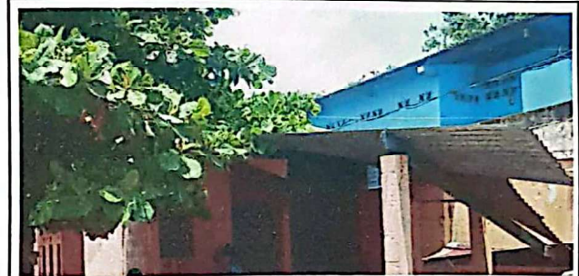
FOTO 4: Suministro e instalación de canales y bajadas de agua
