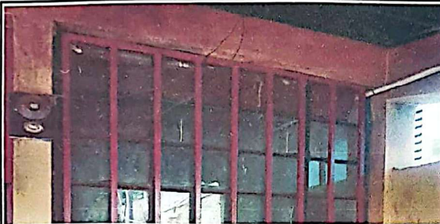
FOTO 9: Suministro e instalación de sistema eléctrico 150 mts
