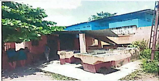
FOTO 7: Suministro e instalación de columnas
