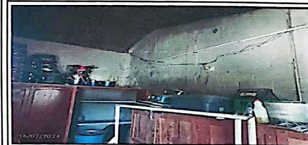
FOTO 5: Suministro y reparación de pared de cocina
