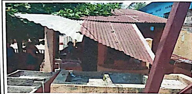
FOTO 3: Sustitución de lámina troquelada Aluzinc calibre 26 para techado de cocina
