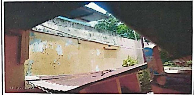
FOTO 2: Suministro y sustitución de estructura metálica para techo de cocina
