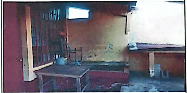
FOTO 8: Mantenimiento y remodelación de cocina
