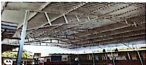
Foto 1: SUMINISTRO E INSTALACION DE LAMINA TROQUELADA C 26.
