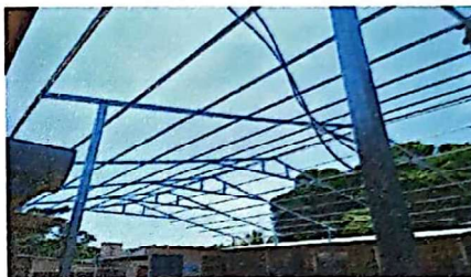
Foto 4: SUMINISTRO E INSTALACION DE BASES PARA SOPORTE DE ESTRUCTURA METÁLICA.
