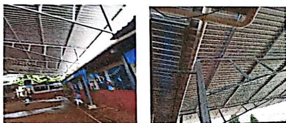
Foto 3: SUMINISTRO E INSTALACION DE CANALES Y BAJADAS DE AGUA PLUVIAL.
