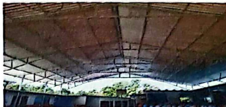
Foto 2: SUMINISTRO E INSTALACIÓN DE ESTRUCTURA DE SOPORTE DE LAMINA.
