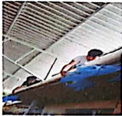
Foto 3: SUMINISTRO E INSTALACION DE CANALES Y BAJADAS DE AGUA PLUVIAL.
