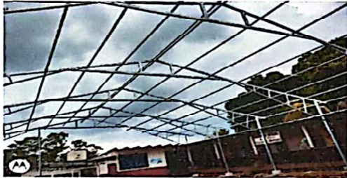
Foto 1: SUMINISTRO E INSTALACION DE LAMINA TROQUELADA C 26.
