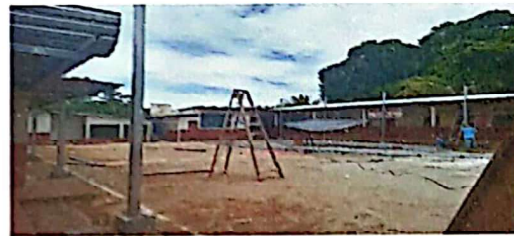
Foto 4: SUMINISTRO E INSTALACION DE BASES PARA SOPORTE DE ESTRUCTURA METÁLICA.
