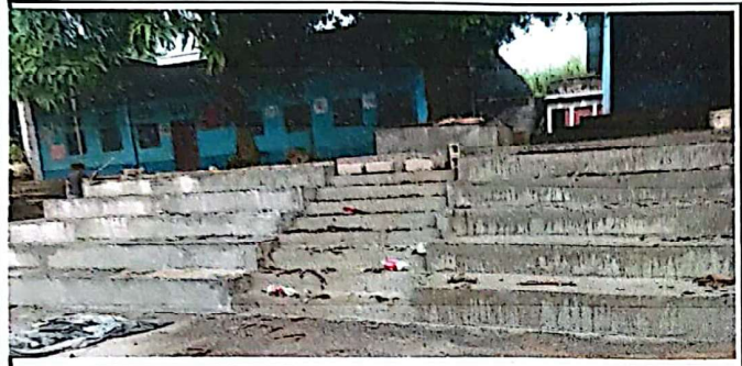
Foto 1: REPARACIÓN DE GRADAS DE INGRESO
