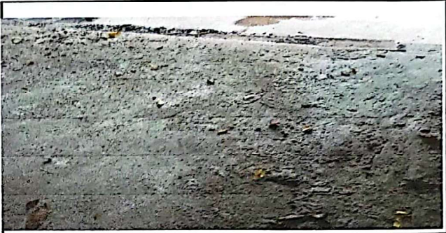
Foto 2: SUSTITUCIÓN DE TORTA DE CEMENTO
