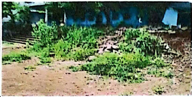
FOTO 1 REPARACIÓN DE GRADAS DE INGRESO
