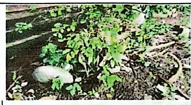
Foto 4: REPARACIÓN DE BORDILLO JARDINERA 1.00X1.00M
