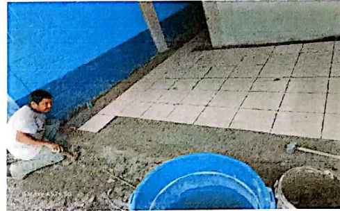
Sumun+B21:H22istro e instalación de piso ceramico 22 mt2 para pasillo
