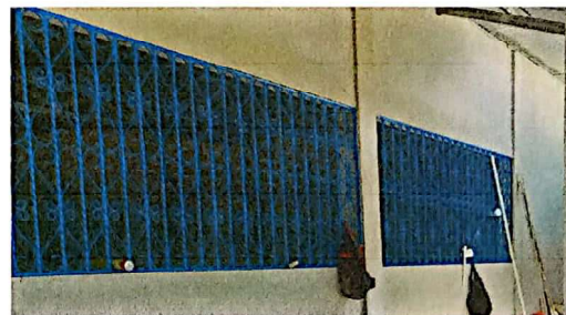
Suministro e instalación de balcones para aula 22.16mts2
