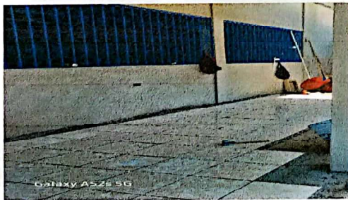
suministro e instalación de piso ceramico para aula 92mts2
