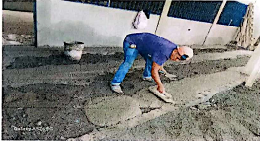
Suministro e instalación de torta de concreto para pasillo
