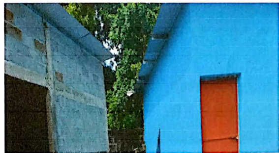
Suministro e instalacion de lámina para pasillo
