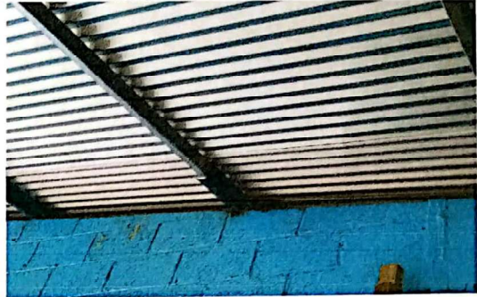
Aplicación de estructura de Soporte para aula
