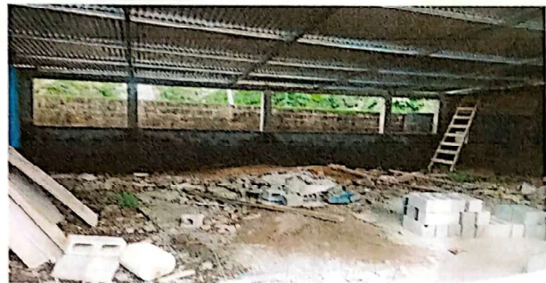
suministro e instalación de torta de concreto para piso de aula 92 mts2
