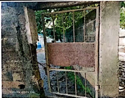
Suministro e instalación de puerta de metal de emergencia
