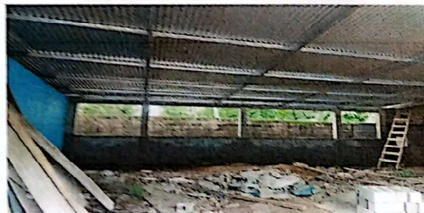
suministro e instalación de piso ceramico para aula 92mts2
