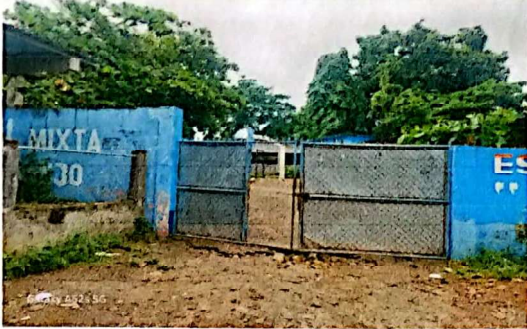
sustitucion e instalación de portón
