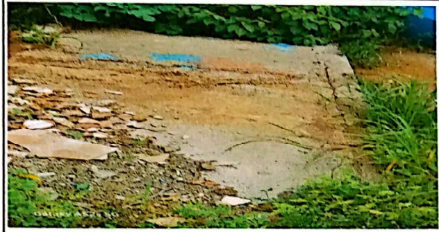
Suministro e instalación de piso ceramico 22 mt2 para pasillo
