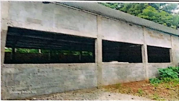
suministro y sustitución de repello de pared 212 mt2
