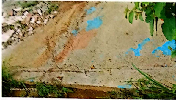
Suministro e instalación de torta de concreto para pasillo
