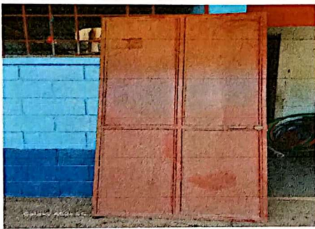
Reparación e instalación de puerta de metal para aula
