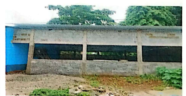
Suministro e instalación de balcones para aula 22.16mts2
