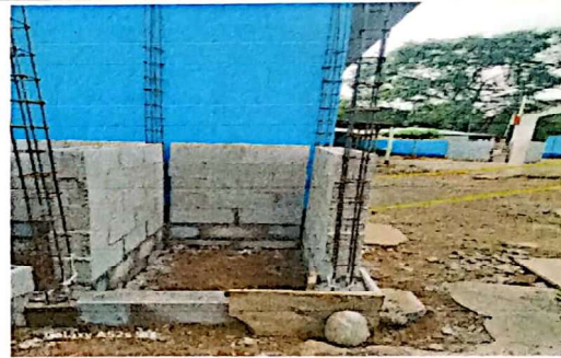
Suministro e instalación de puerta de metal para baño
