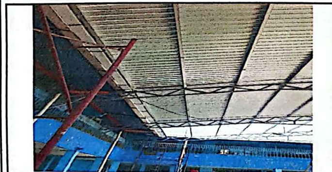
Foto 5: MANTENIMIENTO DE CANCHA CON VIGAS PRINCIPALES TIPO JOIST 225 M2 Y COSTANERAS 6"X2"
