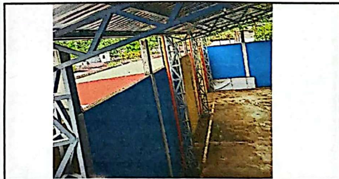
Foto 6: MANTENIMIENTO DE CANCHA CON 4 COLUMNAS METALICAS TIPO JOIST
