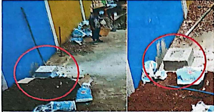
Foto 1: MANTENIMIENTO DE CANCHA CON CIMENTACIONES PILOTES Y PEDESTALES
