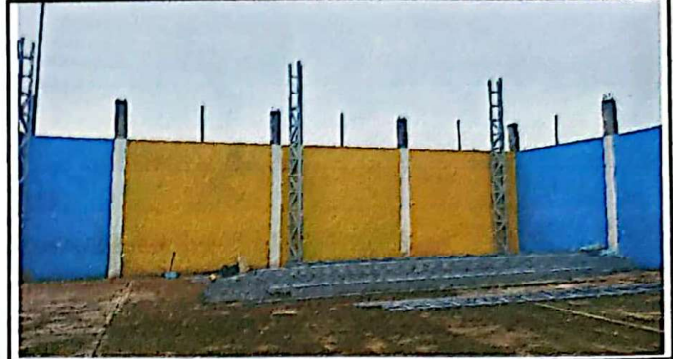
Foto 2: MANTENIMIENTO DE CANCHA CON 4 COLUMNAS METALICAS TIPO JOIST
