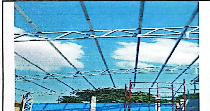
Foto 4: MANTENIMIENTO DE CANCHA CON VIGAS PRINCIPALES TIPO JOIST 225 M2 Y COSTANERAS 6"X2"
