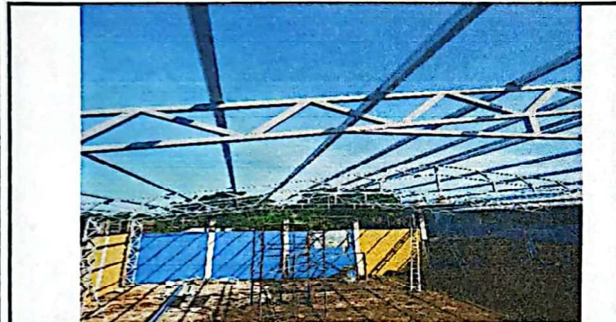
Foto 3: MANTENIMIENTO DE CANCHA CON VIGAS PRINCIPALES TIPO JOIST 225 M2 Y COSTANERAS 6"X2"
