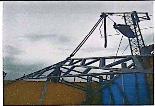
Foto 4: MANTENIMIENTO DE CANCHA CON VIGAS PRINCIPALES TIPO JOIST 225 M2 Y COSTANERAS 6"X2"
