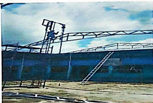
Foto 5: MANTENIMIENTO DE CANCHA CON VIGAS PRINCIPALES TIPO JOIST 225 M2 Y COSTANERAS 6"X2"
