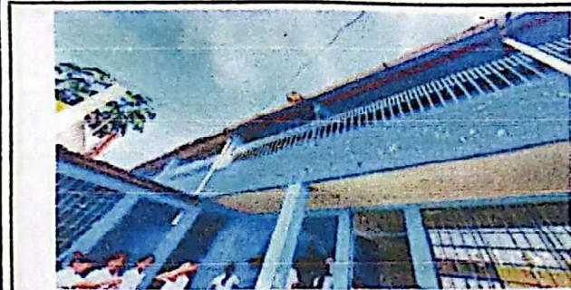
MANTENIMIENTO DE CANCHA CON VIGAS PRINCIPALES METALICAS TIPO JOIST 225 m2 Y COSTANERAS 6"X2"
