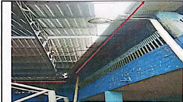
Foto 3: Mantenimiento de cancha con 39m canales de PVC
