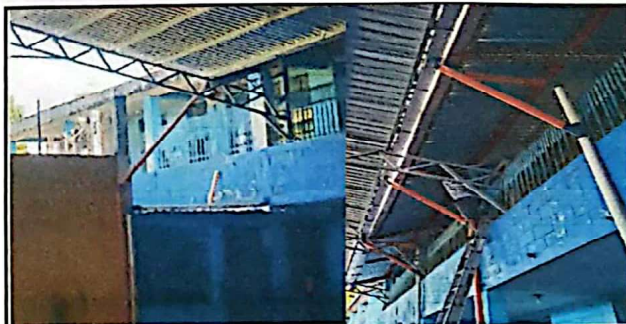
Foto 5: Mantenimiento de cancha con caídas de agua pluvial.
