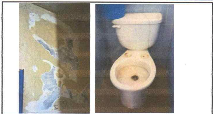
Pintura en muros de 14 aulas y dirección, Sustitución de sanitarios
