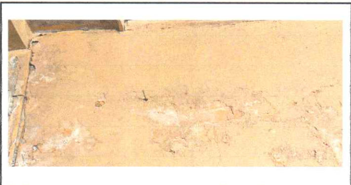
Impermeabilización de muros en 10 aulas
