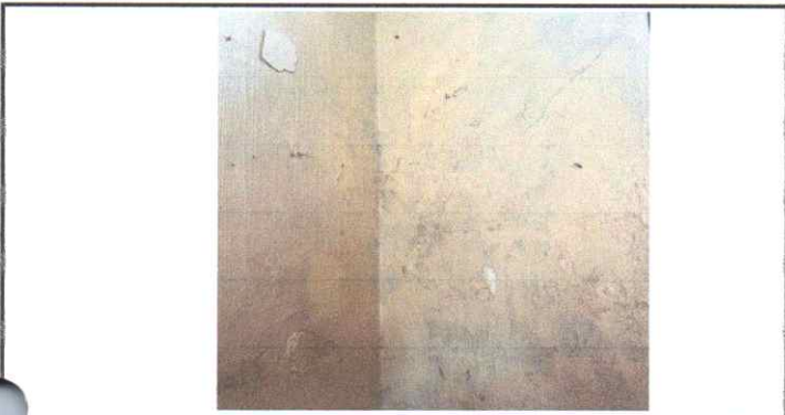
Pintura en muros de 14 aulas y dirección, Sustitución de sanitarios
