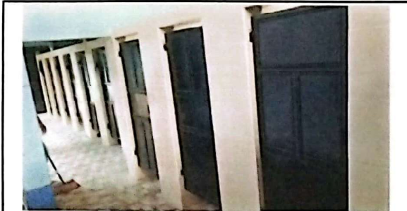
MANTENIMIENTO DE MUROS TABIQUE DE "14" CABINAS DE SANITARIOS MODULO 1 Y MANTENIMIENTO DE "14" PUERTAS METALICAS DE CABINA DE SANITARIOS MODULO 1
