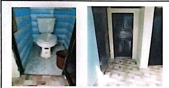
MANTENIMIENTO INODORO INFANTIL DE 1 CABINA DE SANITARIOS MODULO 1
