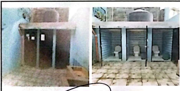
MATENIMIENTO BAJADA PLUVIAL Y PAÑUELO EN LOSA DE CABINA DE SANITARIOS MODULO 2 Y SUSTITUCION DE "3" INODOROS SANITARIOS MODULO 2
